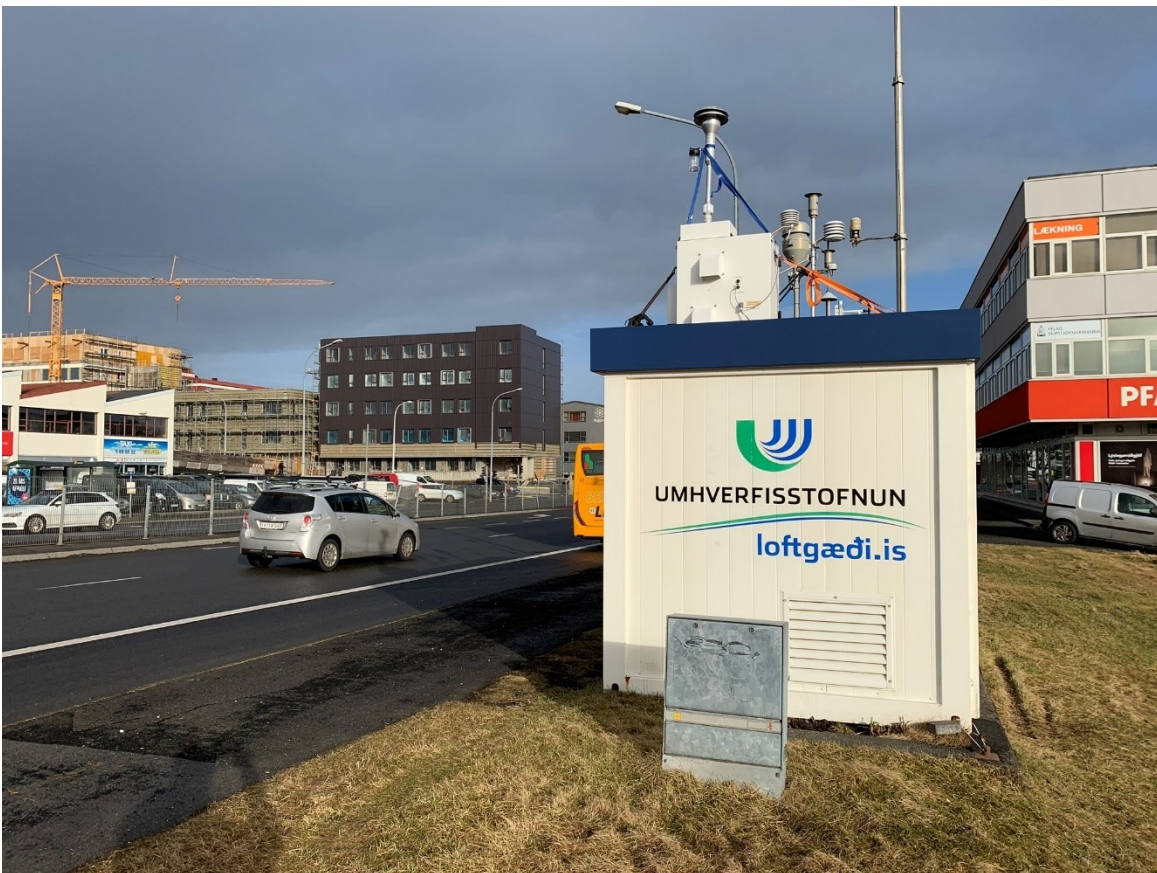
MYND 2 Sýnataki staðsettur uppi á þaki loftgæðastöðvar við gatnamót Grensásvegur og Miklubrautar
